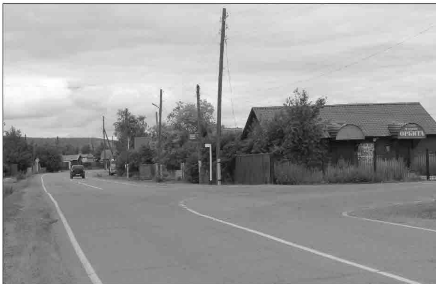
От данного перекрёстка и до конца деревни Краснояря будет проведено уличное освещение
