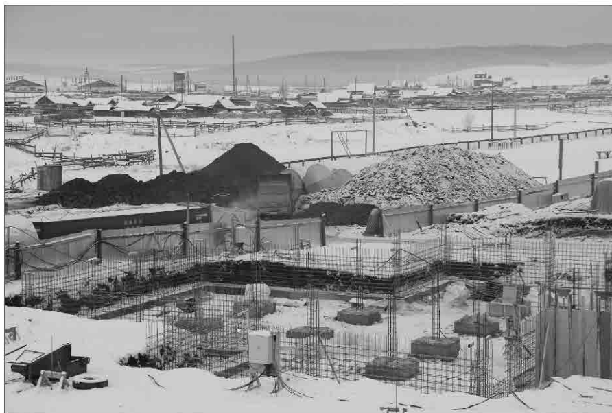
Первый этап строительных работ на объекте КПЦ планируется завершить к Новому году
