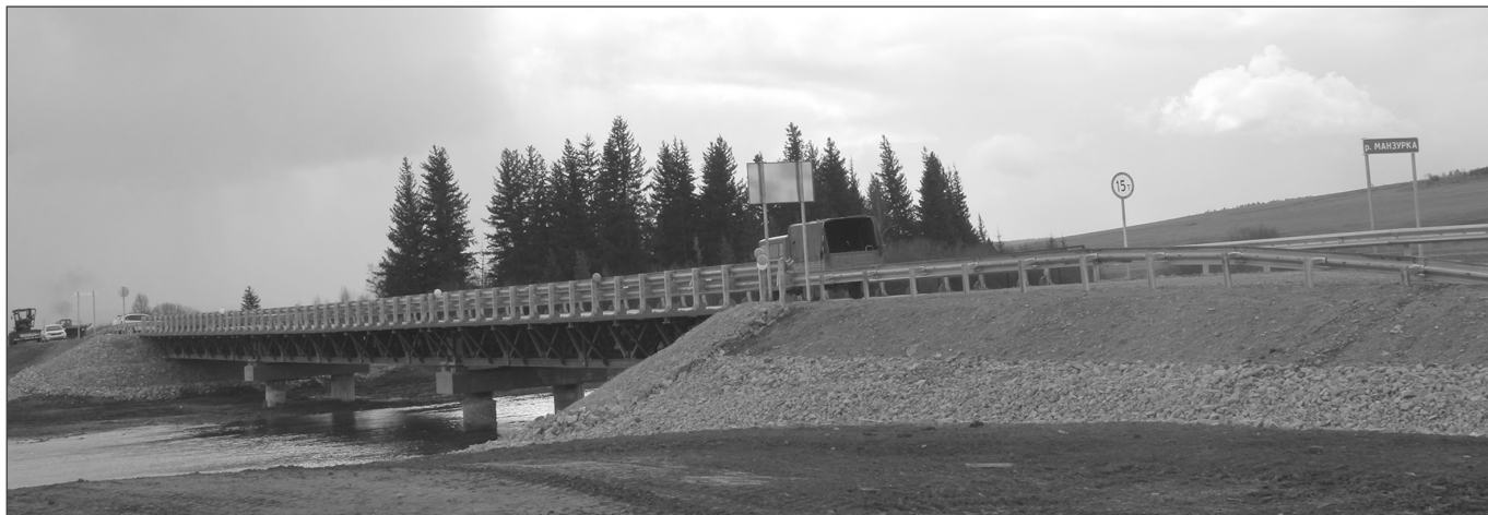
Протяженность моста через реку Манзурка почти 90 метров
