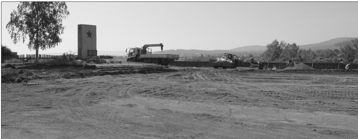
На территории будет уложена новая плитка
