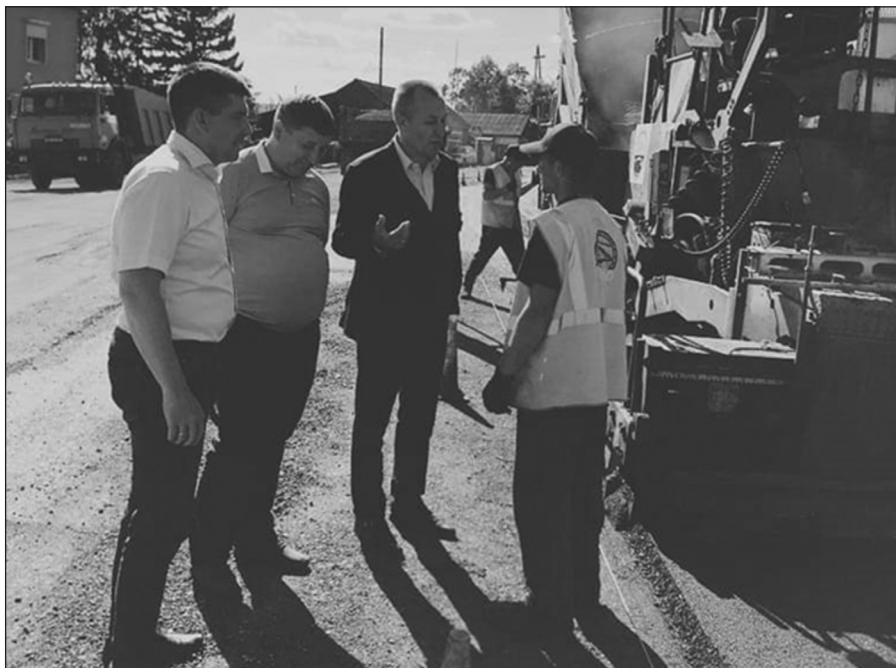
Алексей Гостевский, Евгений Липатов, Николай Труфанов на участке дороги в центре Качуга. Ремонт идёт полным ходом
