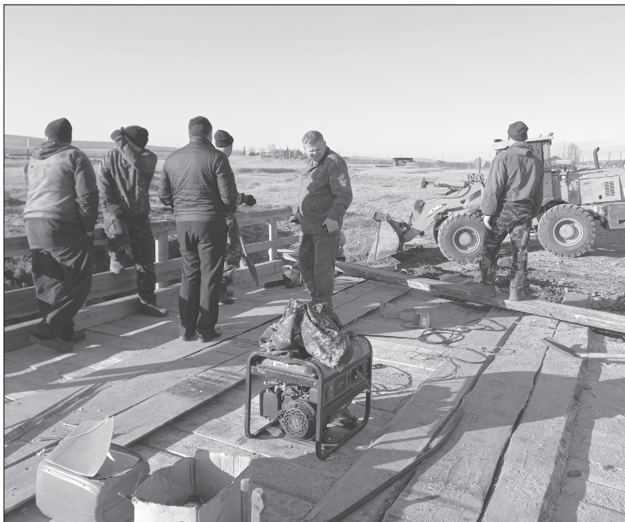
Строительство моста в урочище Чалоты Манзурского сельского поселения
