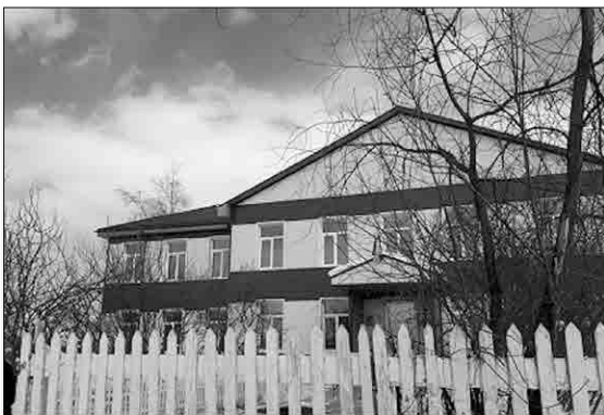
В декабре 2017 года завершен капитальный ремонт Бирюльской школы. Она по-прежнему главный центр жизни села
