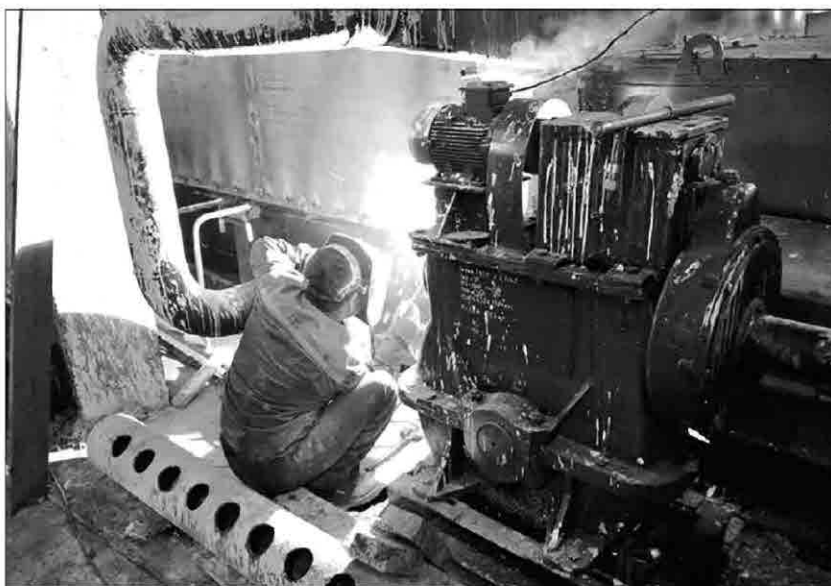
На фото — идут сварочные работы на котле № 4 в котельной «Водогрейная». На объекте работают 26 человек. Частично уже отремонтированы фундаменты под котлами, идет обмуровка котлов. Котлы № 4 и № 6 отремонтируют до начала отопительного сезона, в августе в дома дадут горячую воду, работы по ремонту котла № 5 завершатся к концу сентября, № 7 — к ноябрю. «Все планы, сметы, графики ремонта у нас есть, согласно им и ведутся работы», — сказала новая временно исполняющая обязанности главы Вихоревки Анна Попова
